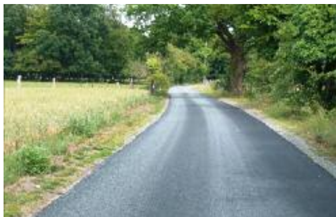
EN COLLABORATION AVEC BAILLY ET TRACY-LE-VAL, RÉFECTION DE LA ROUTE DU QUESNOY ET POSE D'UN ENROBÉ NEUF.
