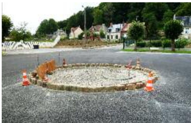
RÉFECTION DE LA PLACE LOONEN
