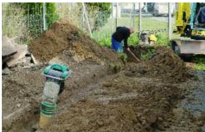
RENFORCEMENT ÉLECTRIQUE DU CLOS POISSON
