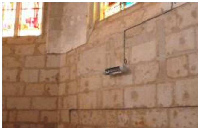
JOINTEMENT DES PIERRES DU CHŒUR DE L'ÉGLISE
