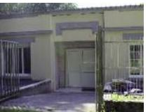
des bandeaux) puis revêtus de deux couches d'enduit de consolidation et d'un enduit de finition. En intérieur, l'isolation et les cloisons ont été remplacées, ainsi que l'installation électrique.
