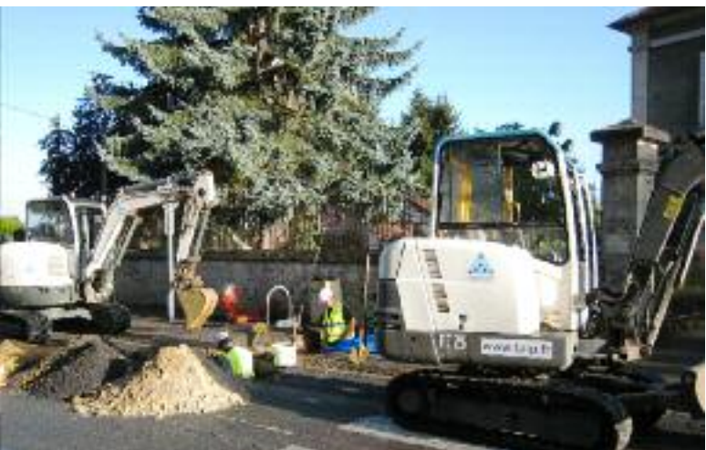
TRAVAUX RUE ROGER SALENGRO
