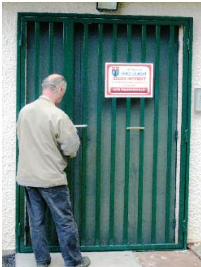
DOUBLE PORTE SUR LE BÂTIMENT COMMUNAL
