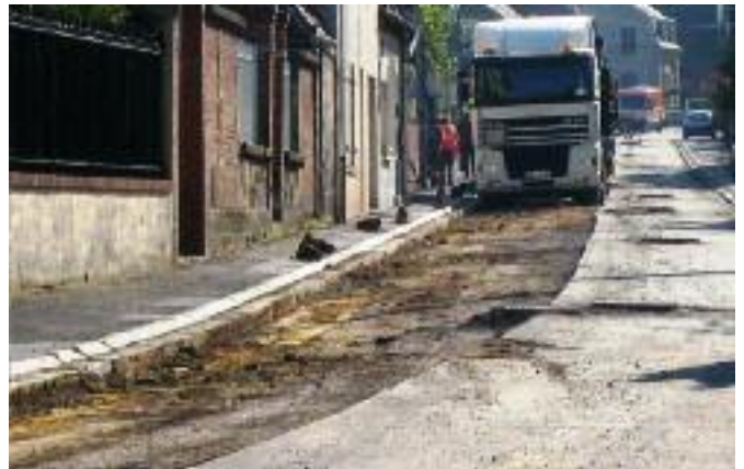
RÉFECTION DE LA CHAUSSÉE, RUE DE LA FLOURIETTE
