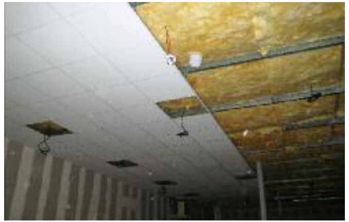
ISOLATION ET RÉNOVATION DE LA SALLE JULES FERRY
