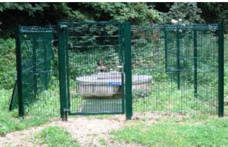
SÉCURISATION DU CAPTAGE
