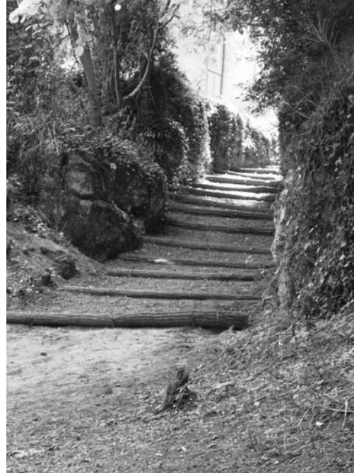
LE CHEMIN DE LA FONTAINE SAINT-BRICE S'EST VU DOTÉ DE MARCHES EN "PAS D'ÂNE" QUI FACILITENT LA CIRCULATION
