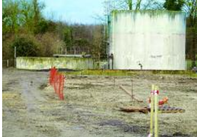
Reconstruction de la station d'épuration.
