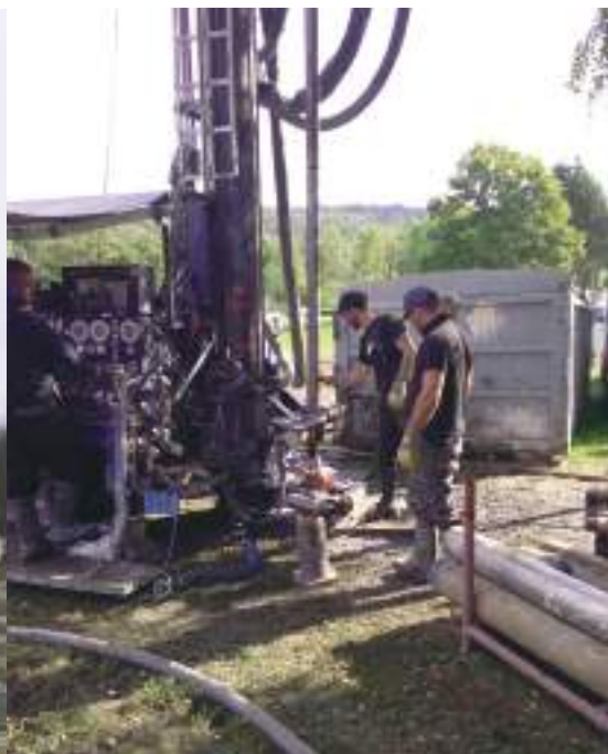
MISE EN PLACE DES SONDES DE GÉOTHERMIE
