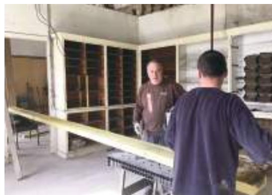
ÉRIC ET CYRILLE PRÉPARENT DES BASTAINGS DE 6,10 M
