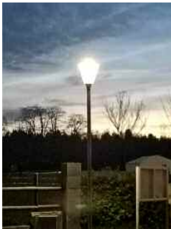
Éclairage aux LEDS, rue des Carrières.
